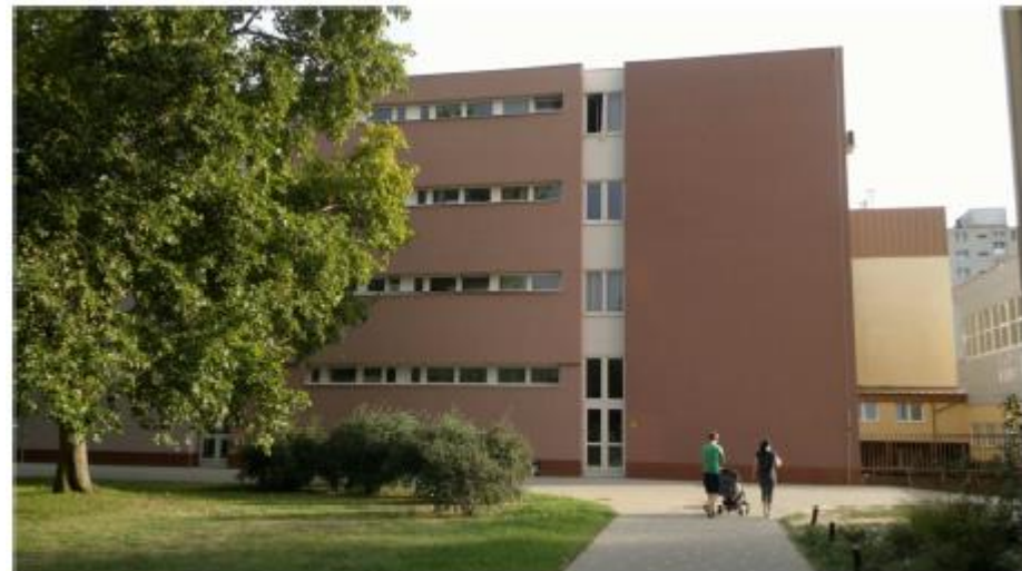
4. Az iskola főépületének északi oldala a kivitelezés után (2)
