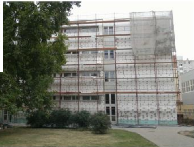
2. Az iskola főépületének északi oldala a kivitelezés közben
