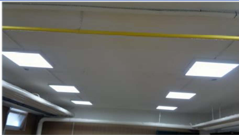
7. A világítási rendszer a korszerűsítése után (1)
