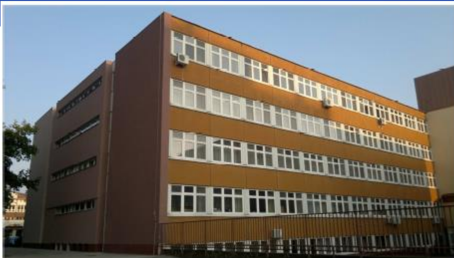
3. Az iskola főépületének északi oldala a kivitelezés után (1)
