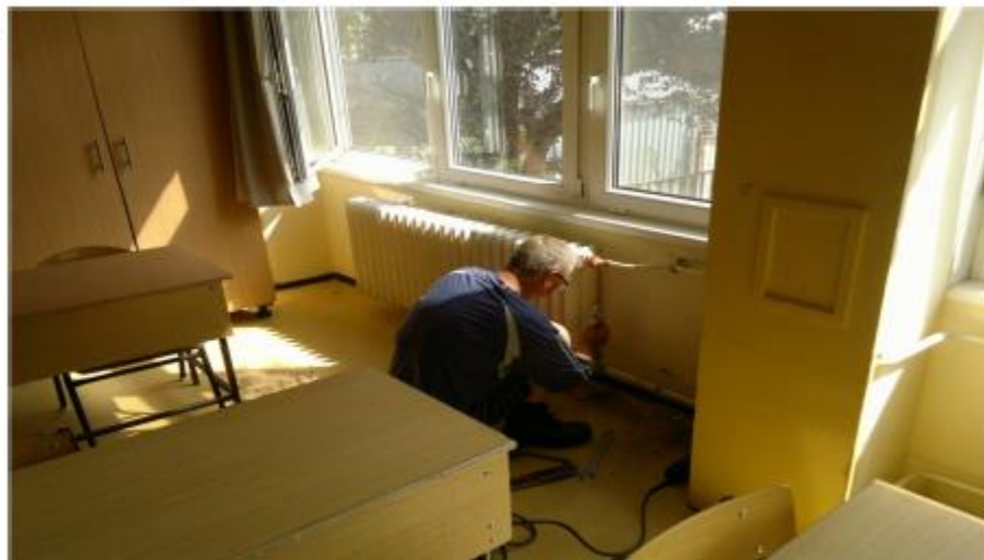
10. A hőleadók szabályozó szelepeinek korszerűsítése közben
