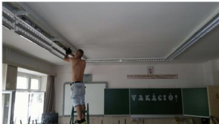
6. A világítási rendszer a korszerűsítése közben
